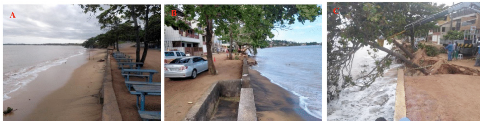
Figura 02. Orla da Praia de Meaípe, com faixa de areia reduzida em processo de retrogradação. Foto A, visada para sul, foto B visada para norte, e na C detalhe da foto B com estrutura de arrimo e avenida da orla destruída pela erosão. Para localização das fotos vide figura 01. Fonte: os autores.
