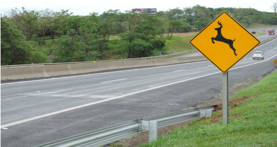
Figura 17 - Barreira “New Jersey” na Rodovia Raposo Tavares
