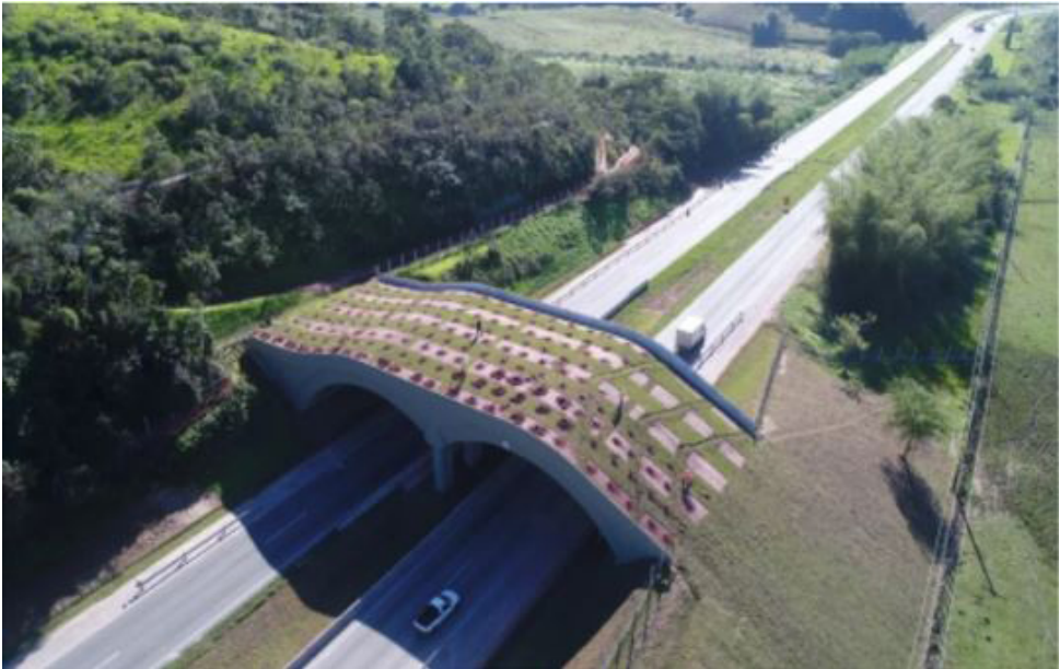
Figura 19 - Primeiro viaduto vegetado em rodovia federal do Brasil fica na BR-101, em Silva Jardim, no RJ
