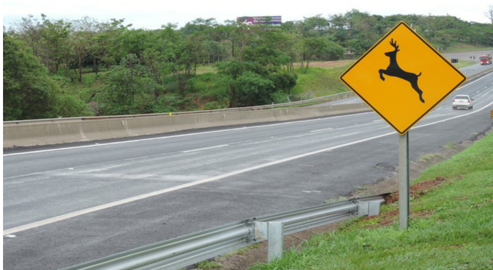
Figura 4 - Barreira de concreto divide as pistas da Rodovia Raposo Tavares (SP-270)
