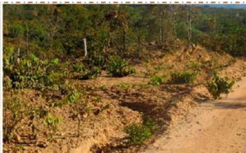
Canaleta em solo.
