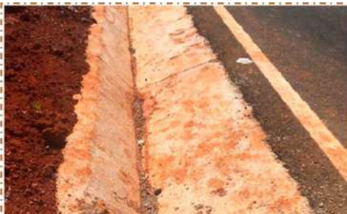
Canaleta em concreto.
