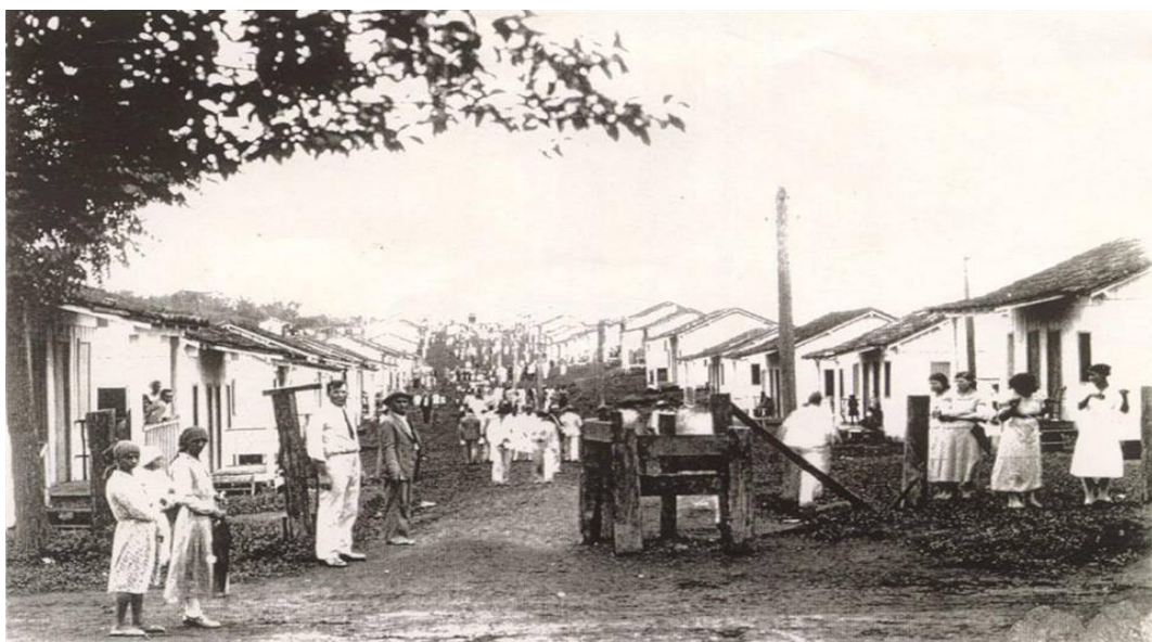
Figura 6 – Rua Santa Bárbara, anos de 1940. Em primeiro plano, a bica de água usada pelos moradores da vila, ao fundo, as casas em madeira destinadas aos operários.
