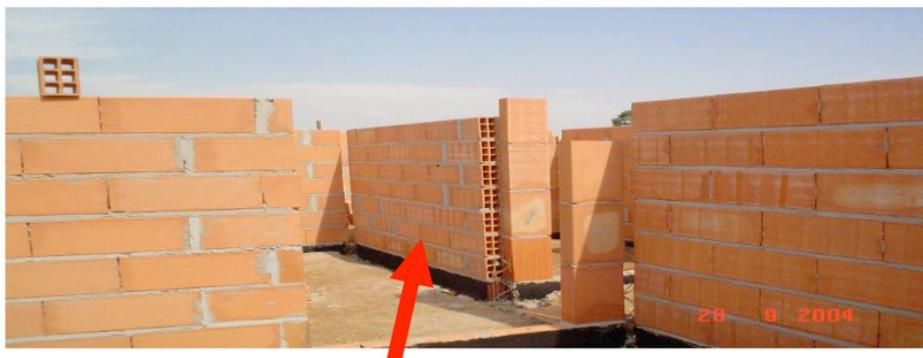
Figura 03: **Alvenaria de vedação** - separação de ambientes Fonte: própria
