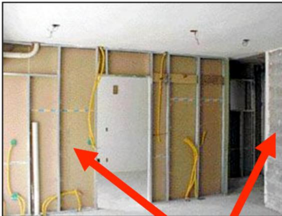
Figura 10a – Misto de Drywall e Alvenaria convencional
