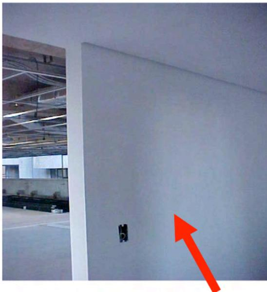
Figura 06: **Parede de Drywall**
