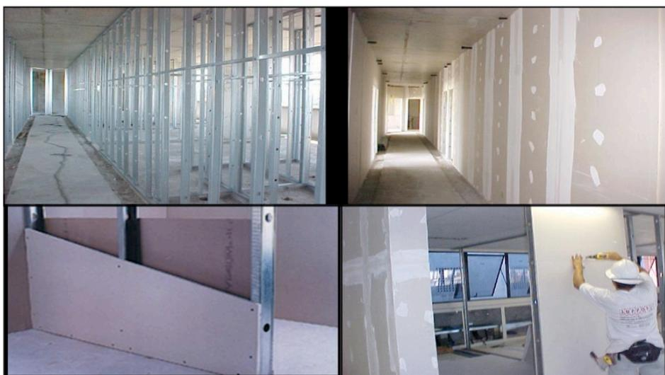
Figura 08: Parede de **gesso acartonado** (ESGA) -
