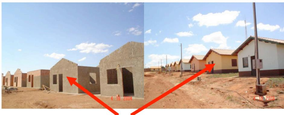
Figura 04: **Alvenaria de vedação** – fechamento externo
