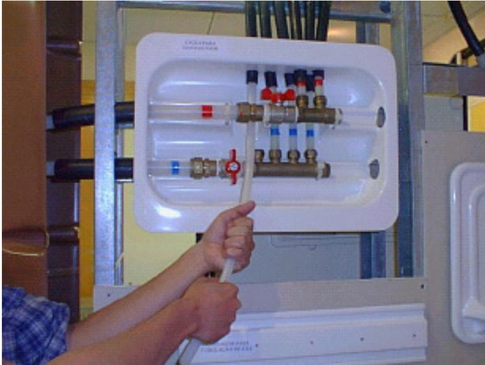
Figura 10: Sistema de tubulação flexível para água (PEX) instalado em parede drywall
