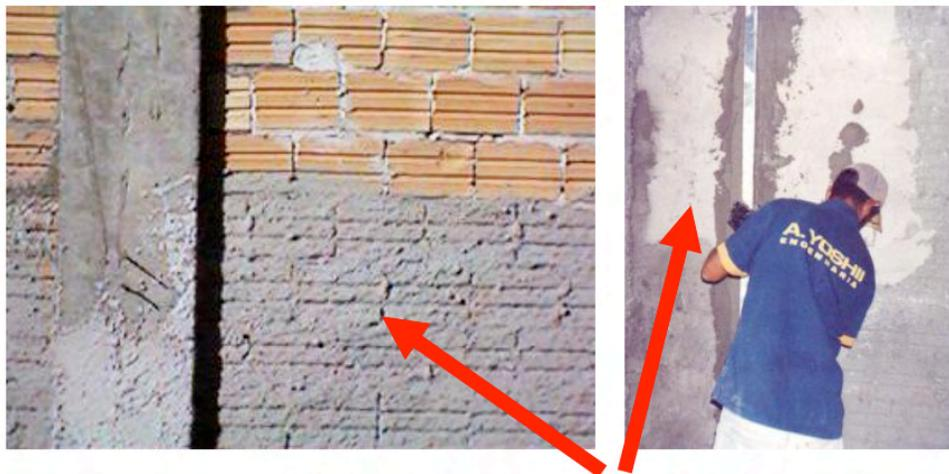
Figura 07: Paredes de **revestimento argamassado**
