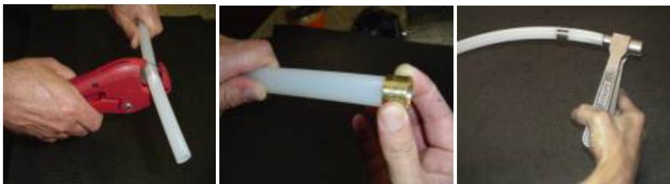
Cortar os tubos PEX exclusivamente mediante ferramenta apropriada. Inserir o Anel. Fazer a bolsa com o expansor.
