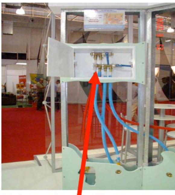
Figura 15 – **Manifold** Fonte: FEHAB/2004
