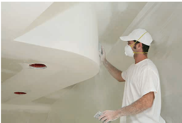
Figura 7 - Aplicação de revestimento com gesso
