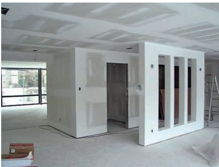
Figura 2 - Paredes de gesso acartonado
