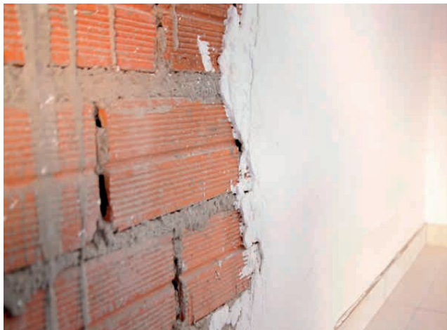
Figura 5 - Revestimento de gesso
