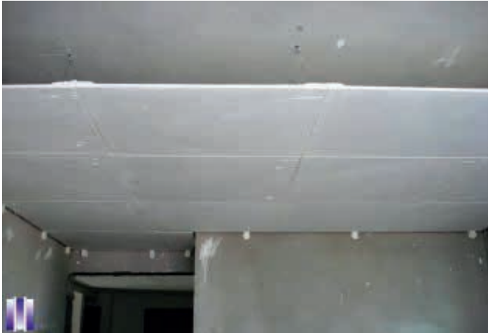
Figura 4 - Rebaixamento / Forro de gesso
