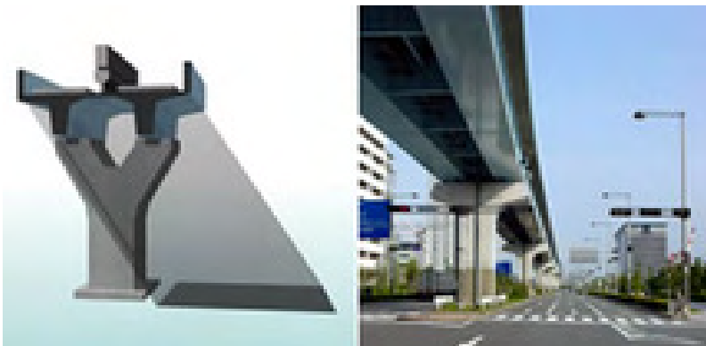
Figura 8 - Sombreamento causado pela infraestrutura de um sistema convencional
