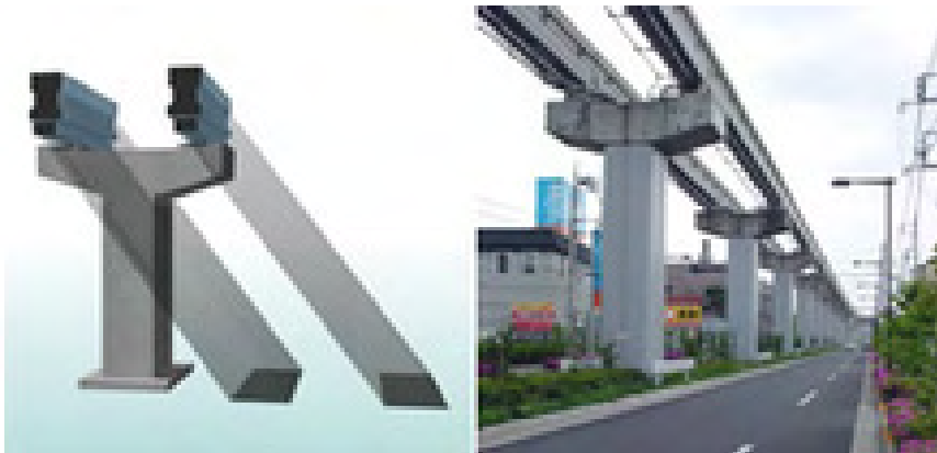
Figura 7 - Sombreamento causado pelas vigas de um sistema de Monotrilho tipo ALWEG
