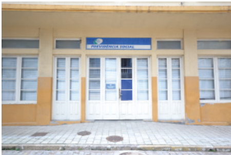
Fig. 10 Adaptação no passeio público para acesso ao edifício público.
