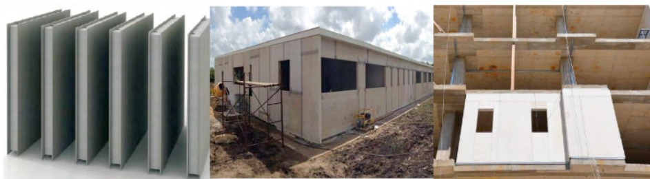
Figura 1 – Sistema de Vedação Externa em Painéis leves, com função estrutural
