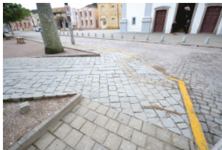
Fig. 15 Adaptação dos passeios públicos.
