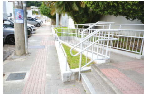
Fig. 11 Rampa de acesso a agência bancária.
