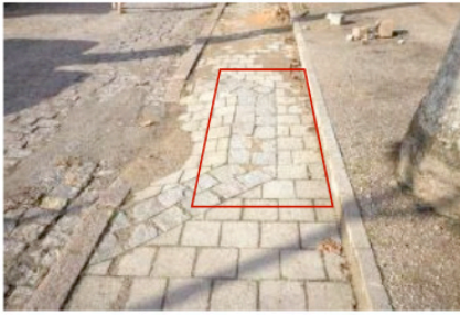
Figs. 18 e 19 Correto rebaixamento do passeio público, porém não se levou em consideração a área de manobra após a rampa, impedindo que o cadeirante execute o giro para seguir o percurso.
