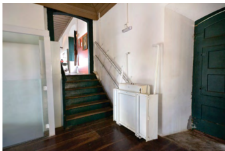
Fig. 07 Plataforma elevatória no segundo pavimento.
