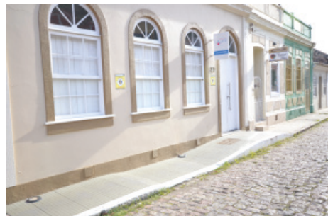
Fig. 13 Adaptação no passeio público para acesso ao edifício privado.
