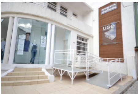
Fig. 12 Intervenção reversível em edifício privado com rampa de acesso.
