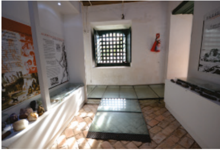
Fig. 08 Rampa interna em aço e vidro temperado, mantendo o visual do pavimento original.
