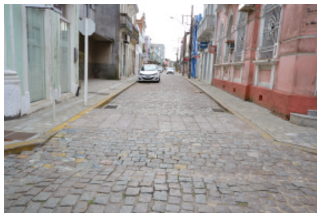
Fig. 14 Elevação da pista nivelando-a aos passeios públicos.
