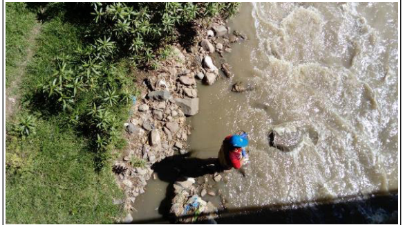
Altura puente de la Facultad de Agronomía UNSAAC- Kayra
