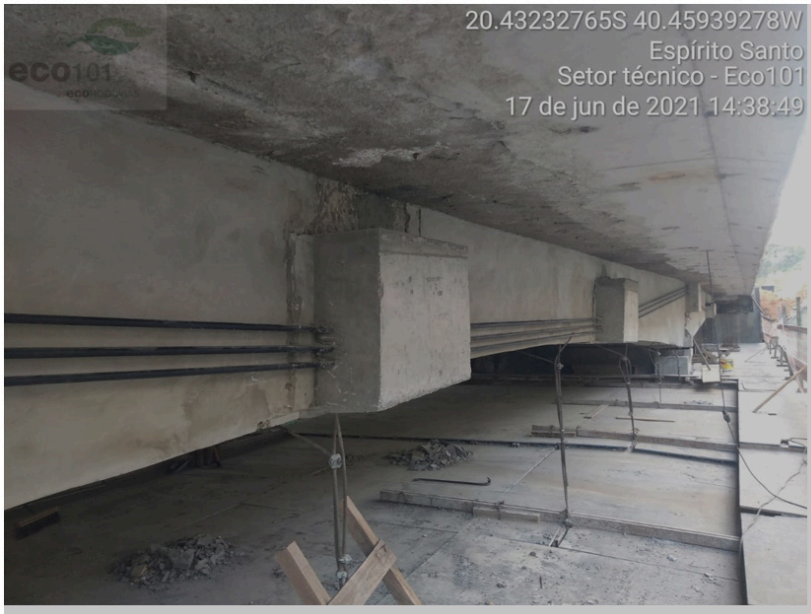
Figura 9 – Foto dos Cabos de Protensão Externa da Ponte Existente.
