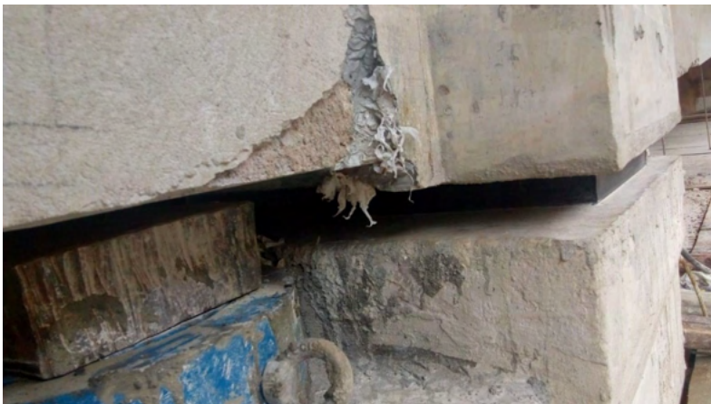
Figura 14 – Aparelho de Neoprene Posicionado.
