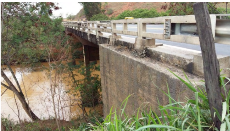
Figura 5 – Vista Lateral da Ponte Existente.
