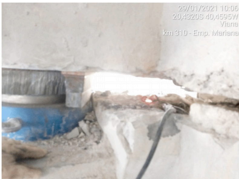
Figura 13 – Corte da Armadura Passante com Arco Elétrico.
