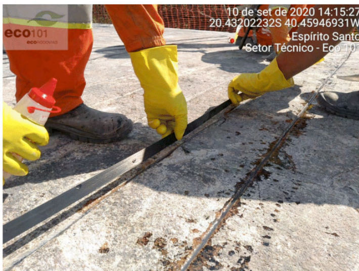
Figura 17 – Aplicação das Lâminas de Fibra de Carbono Inserida.
