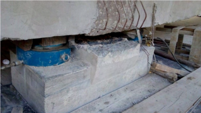
Figura 12 – Suspensão da Longarina para Transferência de Cargas.
