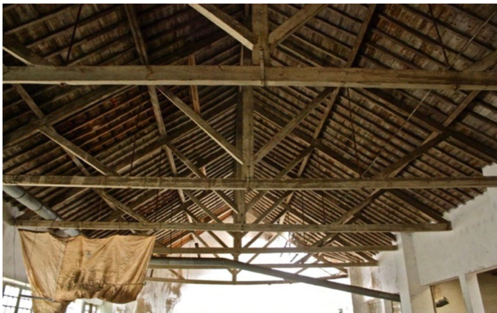
Figura 6: Estrutura da cobertura em madeira.
