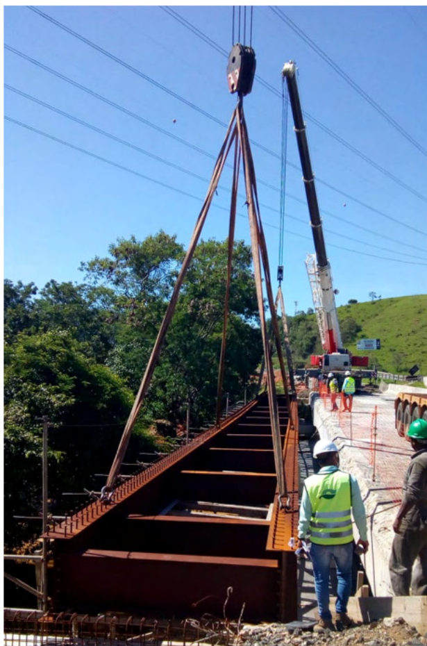
Figura 7 – Lançamento da Estrutura de Aço com Guindastes.
