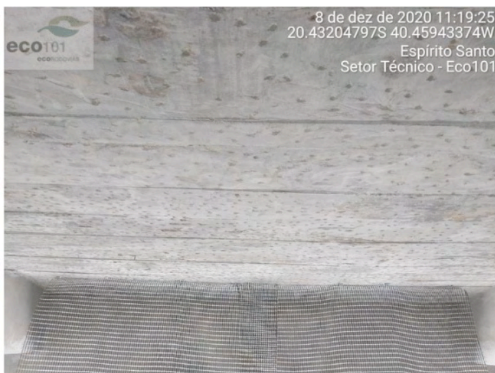
Figura 15 – Aplicação do Reforço da Face Inferior da Laje com Malha de Fibra de Carbono.
