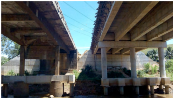
Figura 1 – Vista Inferior da Ponte Nova Concluída e Ponte Existente em Reforma.
