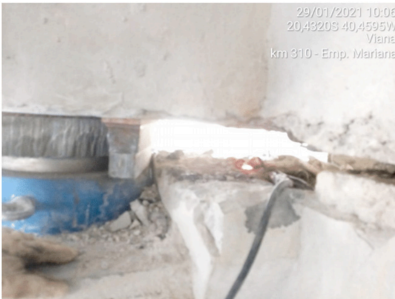
Figura 13 – Corte da Armadura Passante com Arco Elétrico.
