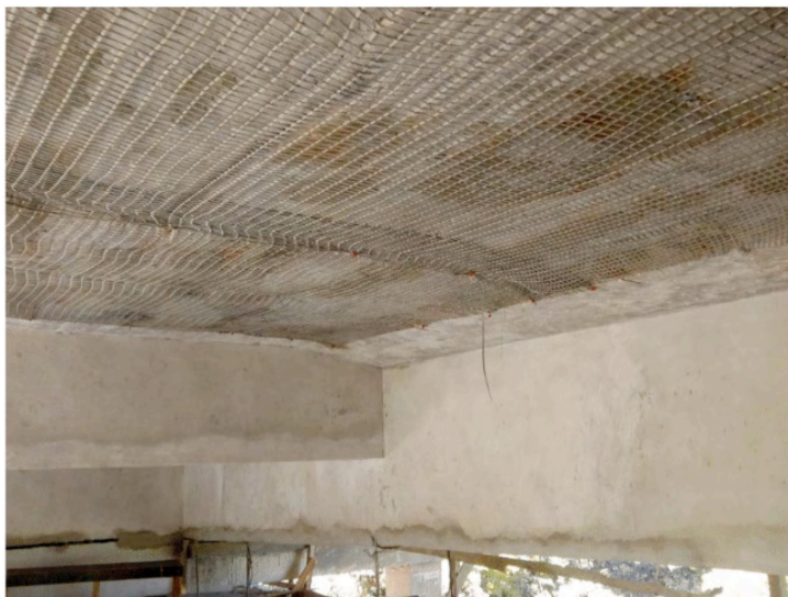
Figura 16 – Aplicação do Reforço da Face Inferior da Laje com Malha de Fibra de Carbono.
