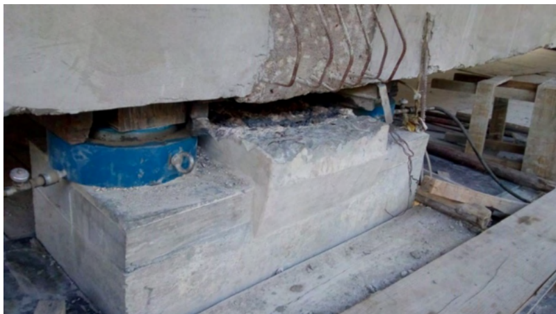
Figura 12 – Suspensão da Longarina para Transferência de Cargas.
