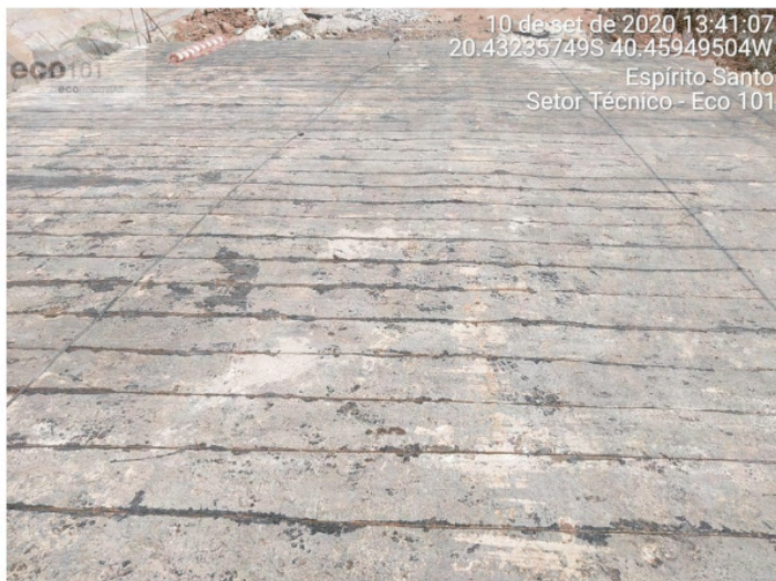
Figura 18 – Face Superior da Laje Reforçada com Lâminas de Fibra de Carbono Inserida.
