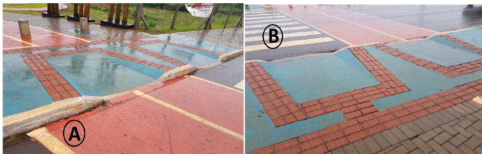
Figura 13: Calçadas com piso podotátil e rebaixamento.
