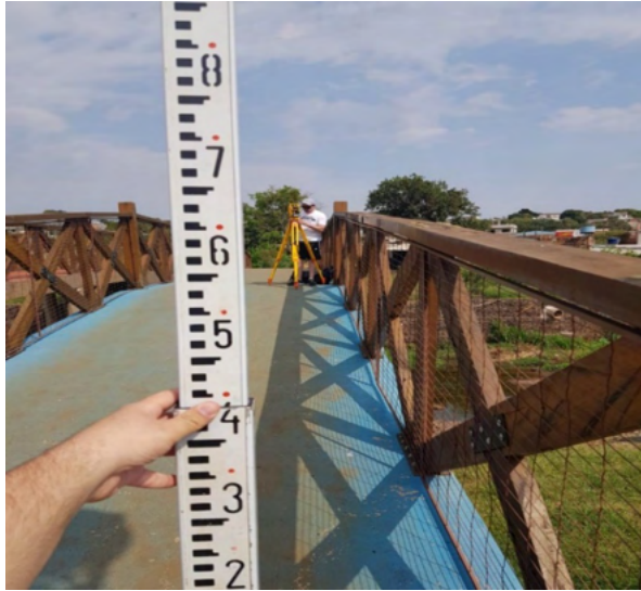
Figura 9: Medição in loco das rampas no Ecopark.
