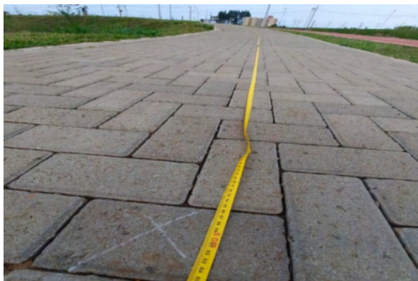
Figura 11: Rampa presente na zona B.
