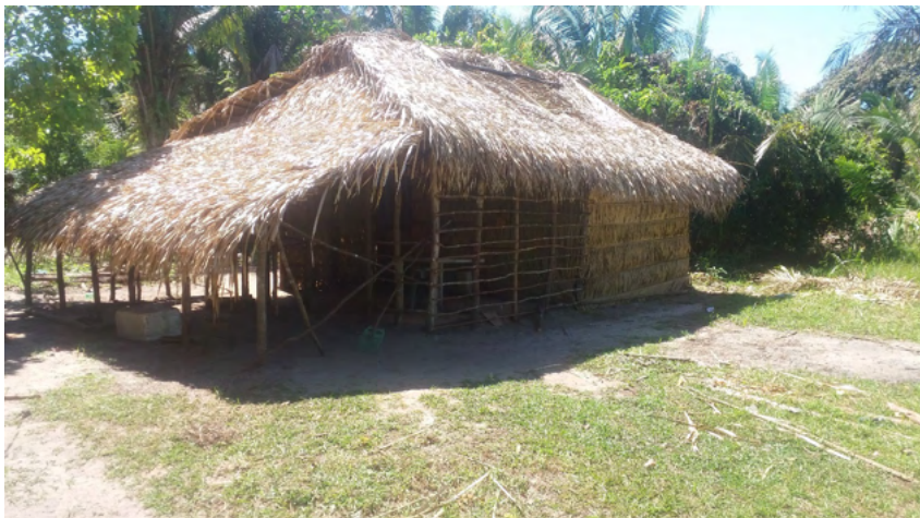
Fotografia 9 - Uma moradia edificada em pau a pique e coberta palhas de pindoba – [jul./2020]
