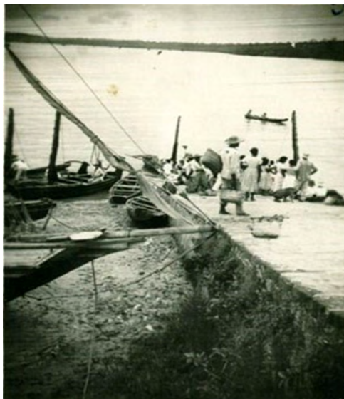
Figura 5 - Vista da rampa – [19--]
