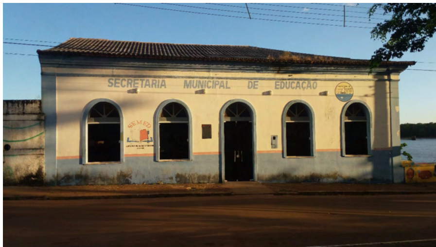
Fotografia 14 - Fachada da Secretaria Municipal de Educação – [jul./2020]
