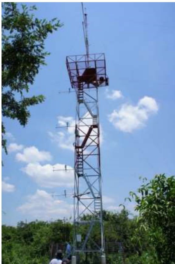
Figura 1 – Torre micro meteorológica construída na Base Avançada de Pesquisas do Pantanal.
