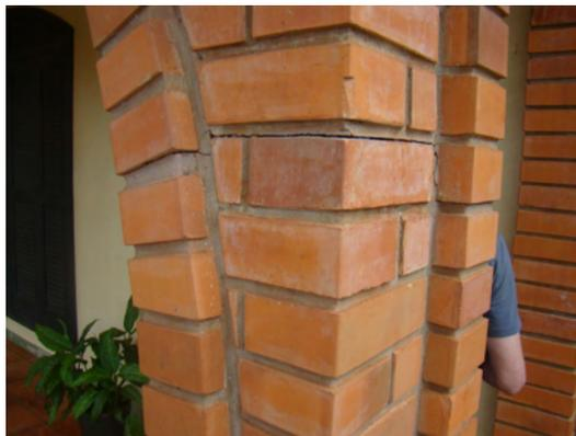
Figura 16 – Fissuras nos pilares de alvenaria sem armadura.
