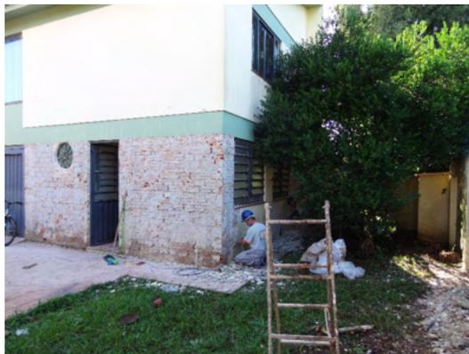
Figura 6 – Ensaio destrutivo parede externa lavanderia.
