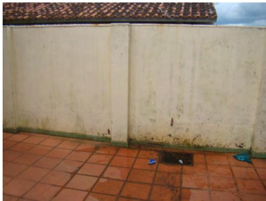
Figura 14 - Fungos e mofo junto a parede norte no pátio.
