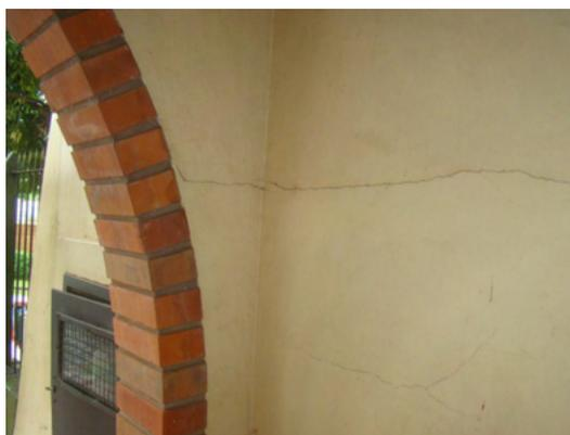
Figura 17 - Fissuras devido a infiltração de água pela algeroz do vizinho.
