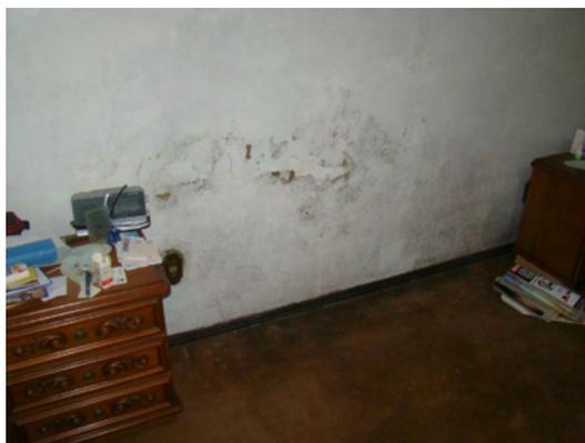
Figura 10 - Umidade generalizada parede interna sul dormitório 01.
