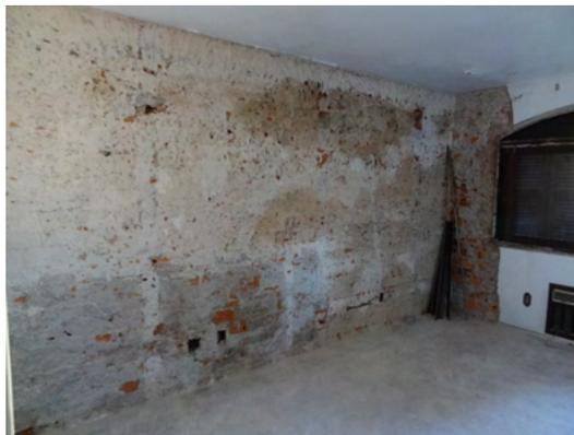
Figura 11 - Ensaio destrutivo parede interna sul dormitório 01.
