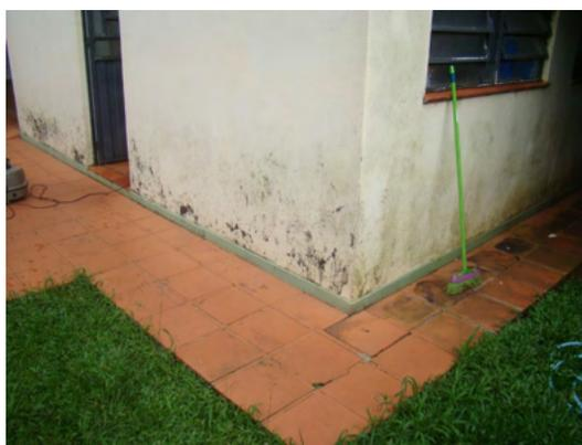
Figura 5 – Umidade ascendente parede externa lavanderia.
