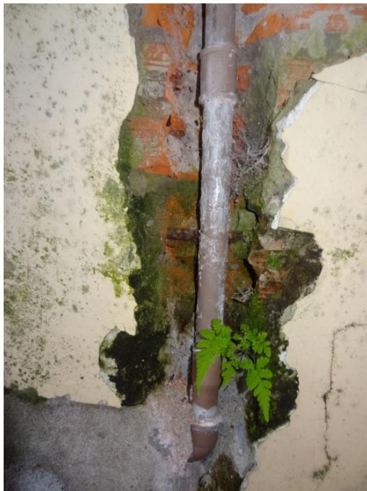
Figura 12 - Fungos e mofo junto a tubulação de entrada de água.
