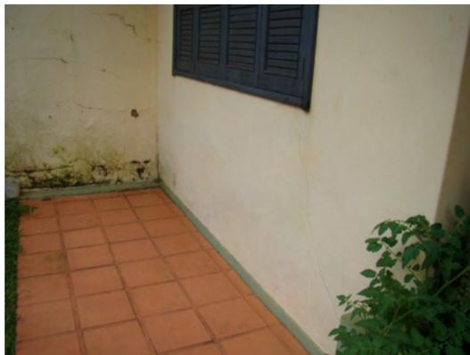
Figura 3 - Umidade ascendente parede externa dormitório 02.
