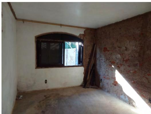
Figura 9 - Ensaio destrutivo parede interna sul dormitório 02.
