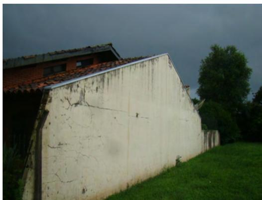
Figura 19 - Fissuras generalizadas na parede externa sul dos dormitórios 01 e 02.
