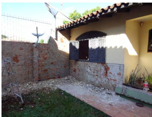
Figura 4 - Ensaio destrutivo parede externa dormitório 02.
