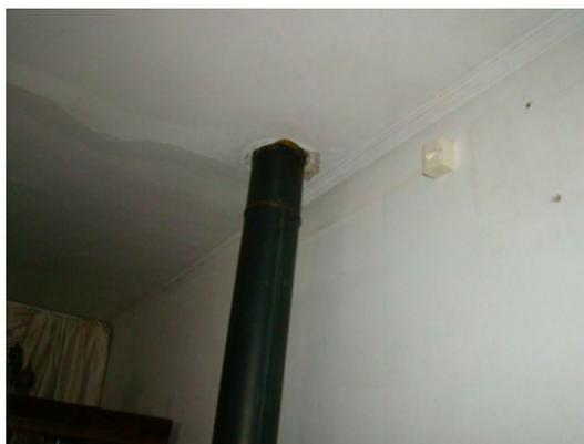
Figura 7 – Umidade na laje devido a umidade proveniente da cobertura.
