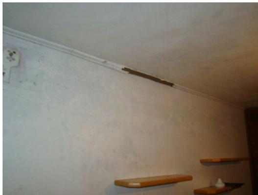
Figura 8 - Umidade generalizada parede interna sul dormitório 02.
