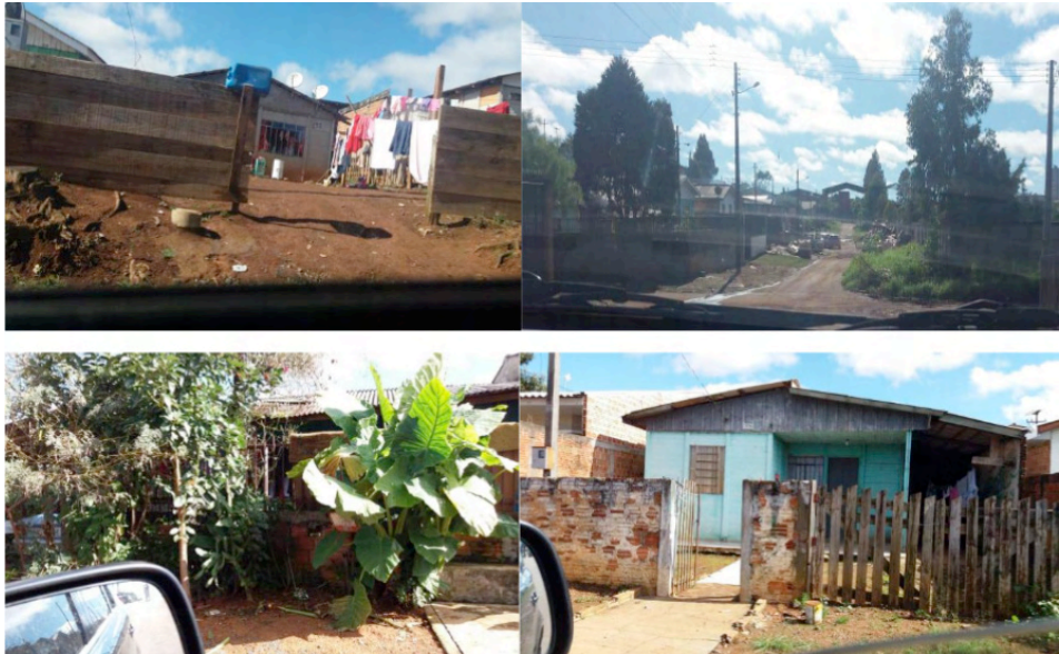
Figura 4 - Precárias infraestruturas habitacionais no bairro Industrial-Xarquinho.
