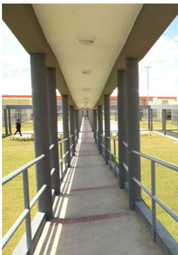
Fotografia 2 – Corredor de acesso às casas
