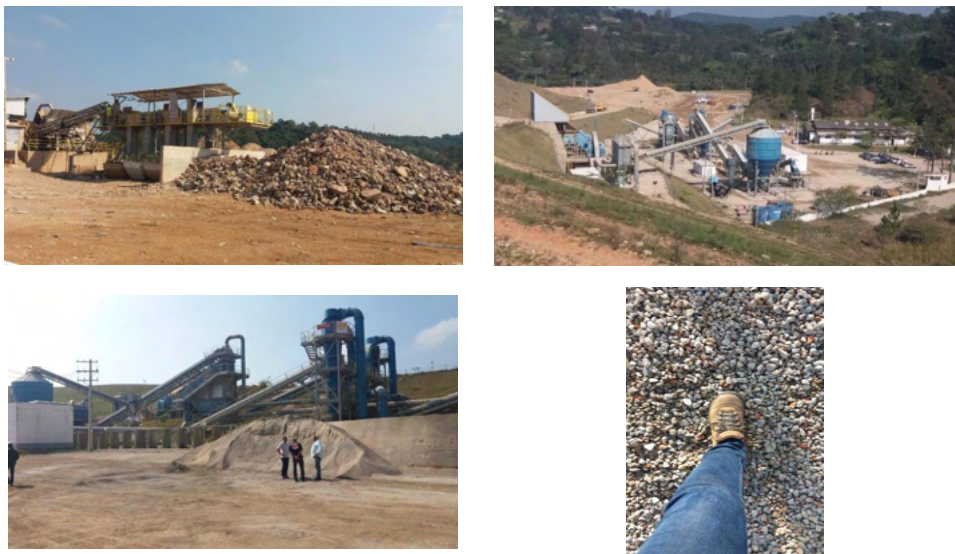
Figura 1 - Visão geral - URV Construção Civil Grajaú.
