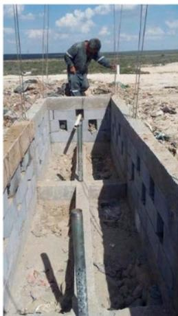
Imagen 5. Preparación para la base del quemador.
