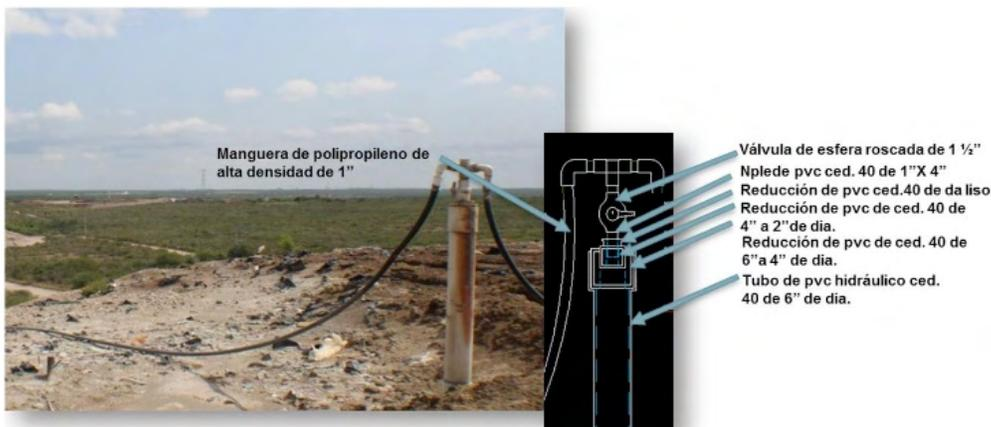
Imagen 4. Colocación de los puntos de respiración y conexión de las mangueras para dirigir el biogás.
