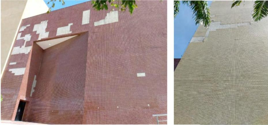
Figura 2-Destacamento das pastilhas cerâmicas. Fachada lateral esquerda.
