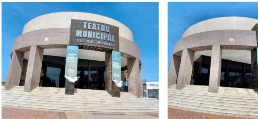
Figura 1-Destacamento do granito. Fachada principal.
