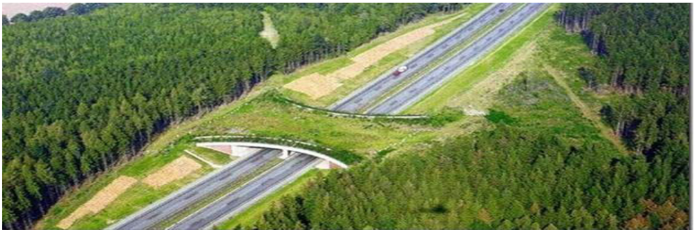
Figura 3 - Ponte verde na Highway A20, Alemanha, auxilia a travessia de animais silvestres
