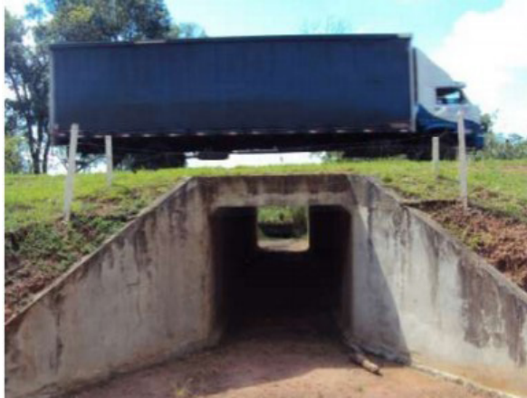
Figura 1 – Passagem de fauna subterrânea
