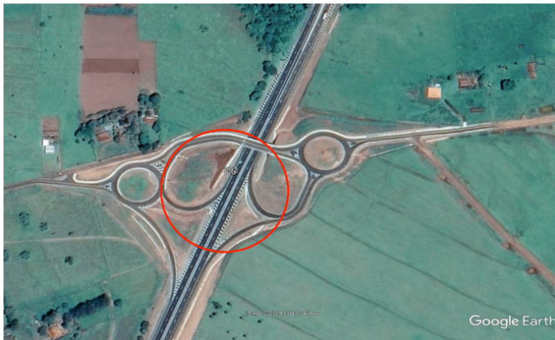
Figura 5 – Ilustração do local onde não existe uma passagem de fauna
