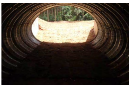
(a)– Visão interna da passagem de fauna
