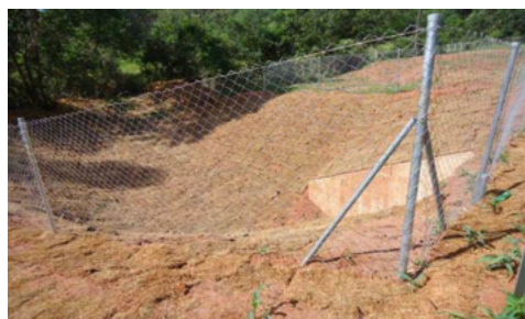
(b) Visão externa da passagem de fauna
