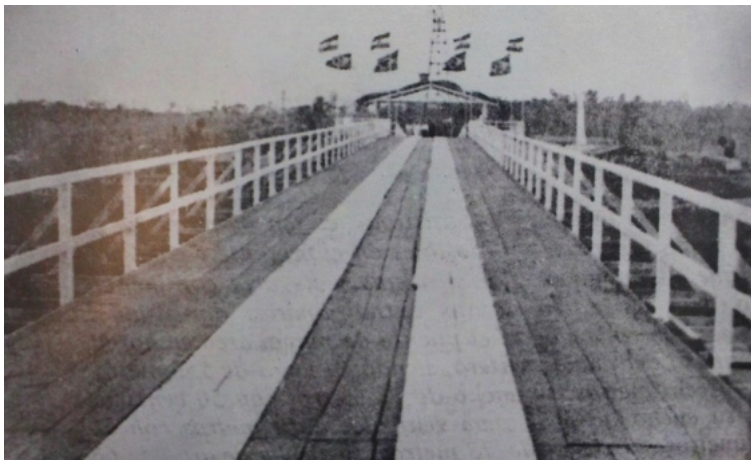
Imagem 11 – As madeiras colocadas para a pré-inauguração da ponte em 1961.
