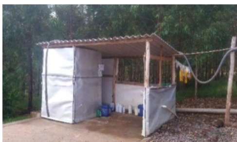
Figura 1-B (Produtos fitossanitários no piso)
