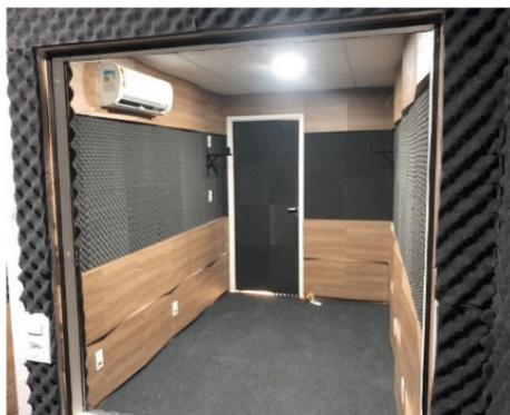
Figura 07 – Instalação das espumas acústicas.
