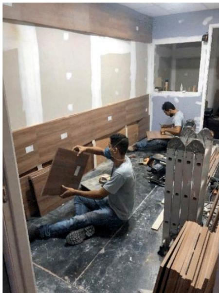
Figura 06 – Instalação do drywall e defletores de som.
