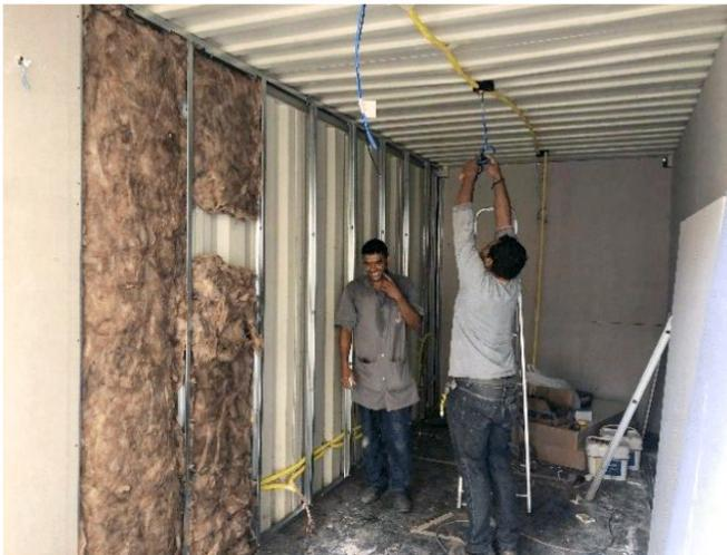
Figura 05 – Tratamento termo acústico do interior do container.
