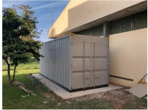
Figura 04 – Concretagem da base e locação do Container.
