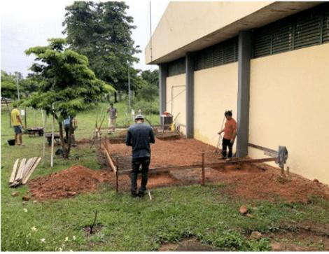
Figura 04 – Nivelamento do terreno e gabarito da obra.
