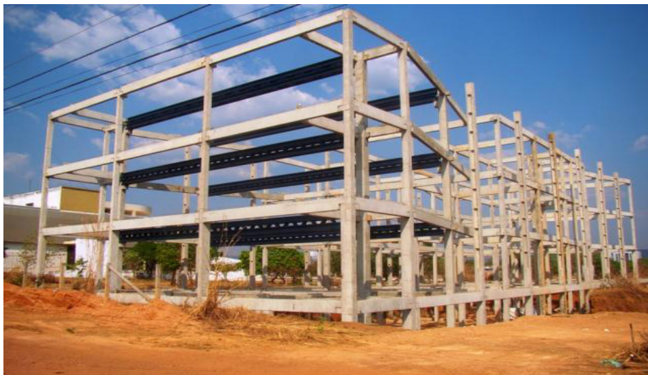
Figura 32: Estrutura com vigas de concreto.
