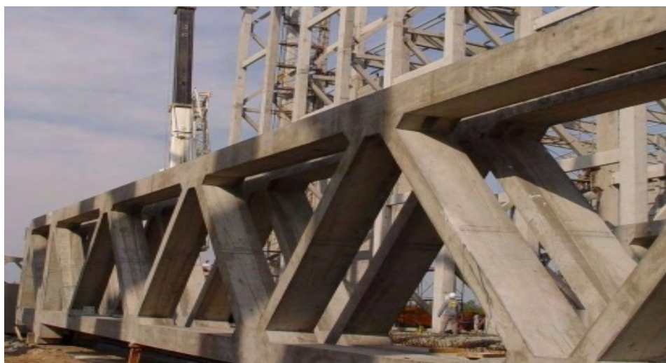
Figura 22: Treliça feita de concreto.
