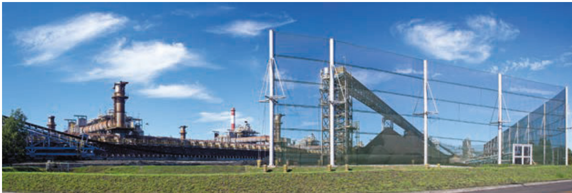
Figura 2 – Wind Fence instalada na área da Coqueria Heat Recovery.
