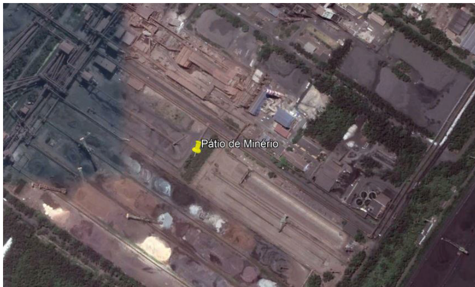
Figura 3 - Imagem aérea do local de implantação do experimento no Pátio de Estocagem de Minério da ArcelorMittal Tubarão.
