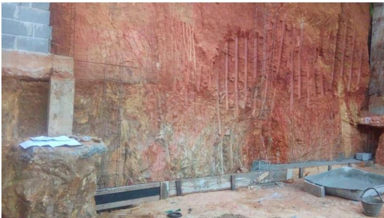
Figura 6 - Talude de corte (Acervo Fotográfico do Autor)..
