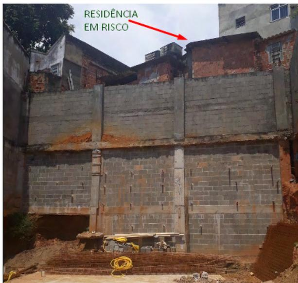
Figura 8 - Muro novamente construído (Acervo Fotográfico do Autor)..
