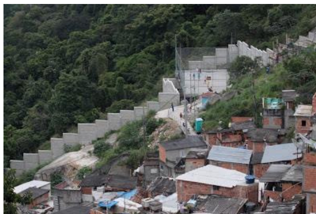
Figura 3. O muro da discórdia.
