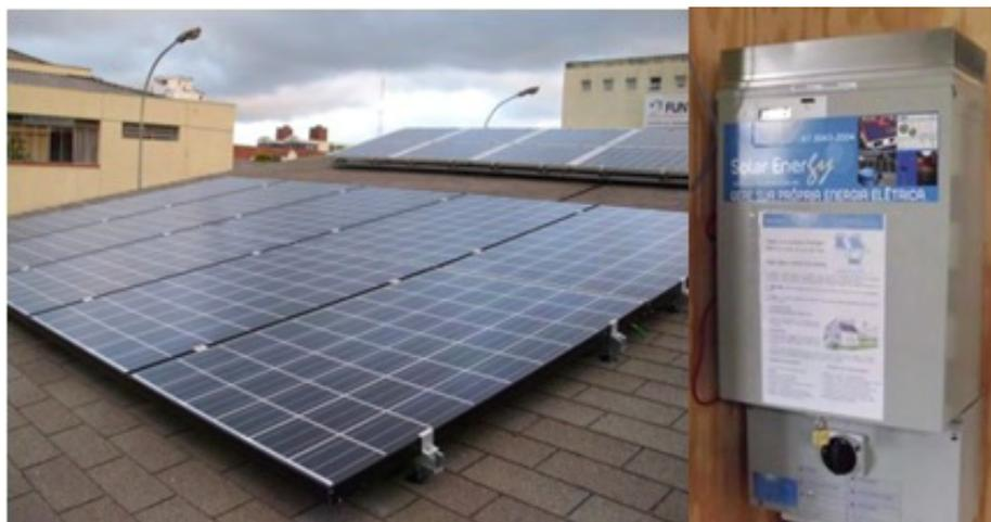
Figura 93: Vista dos painéis do EV e do inversor - Sede Centro [6] [59].
