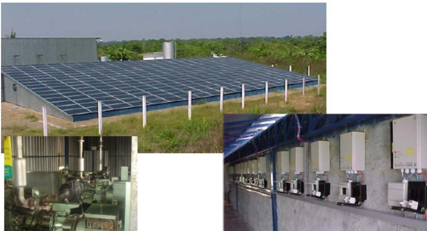
Figura 90: Sistema isolado híbrido fotovoltaico-diesel instalado em Nova Mamoré <sup>[19]</sup>.
