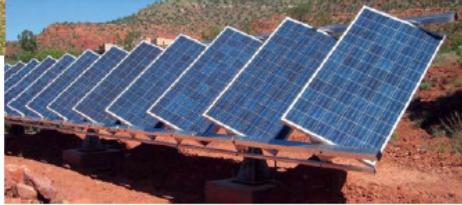
Seguidor de um eixo
