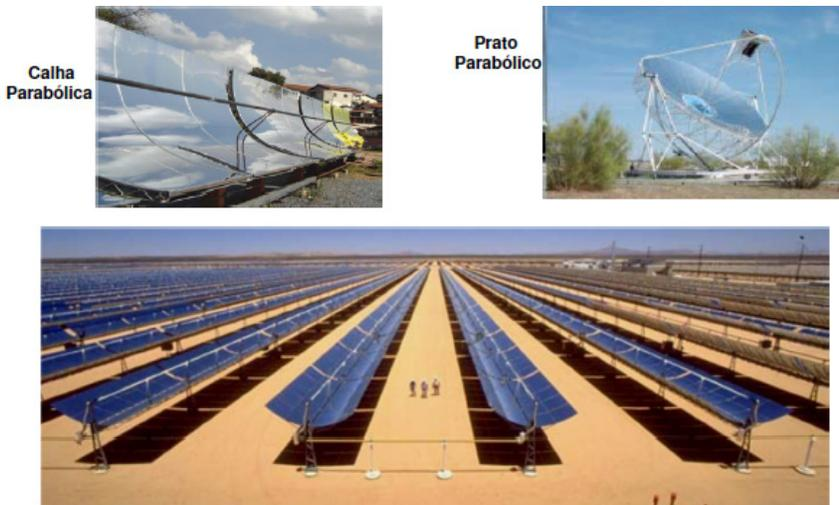
Figura 21: Sistemas com concentradores solares térmicos [19].
