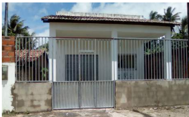
Figura 1: Casa da Mangaba –Sede
