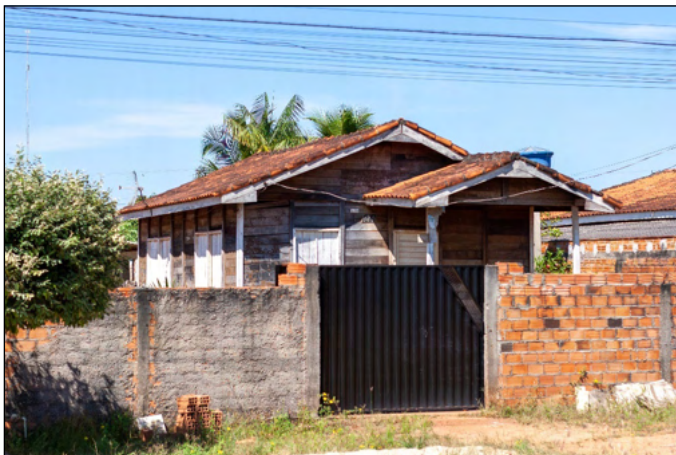
Figura 3. Imagem de moradia desocupada mas em bom estado de conservação.
