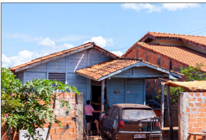
Figura 4. Imagem de moradia necessitando de reparos.
