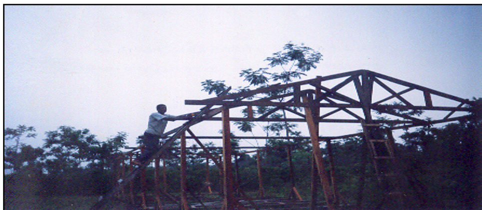
FIGURA 03 – Marquelino, F. S. Construção da escola Bem-Aventura. Projeto Adote uma escola. Extrema – Porto Velho – Rondônia. 2002.
