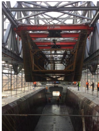
Figura 11. Transporte de un módulo de acero de refuerzo con los puentes grúas del M1-90-S.
