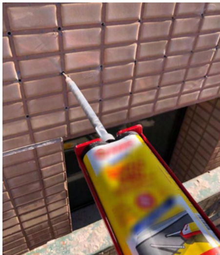
Figura 5. Injeções da resina epóxi.
