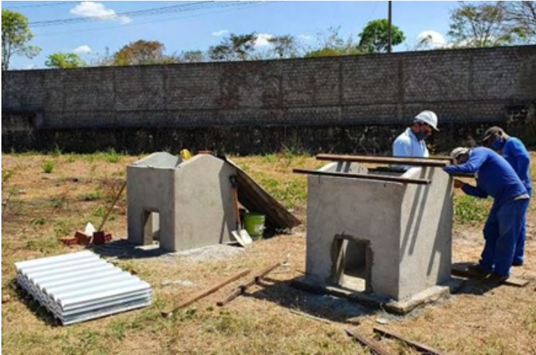
Figura 3: Processo construtivo das telhas sanduiche.
