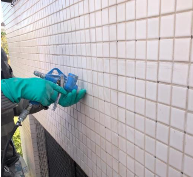
Figura 4. Limpeza dos furos utilizando ar comprimido.
