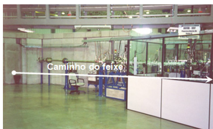
Figura 2: Foto da tubulação do anel para a linha DO9B – XRF do LNLS.
