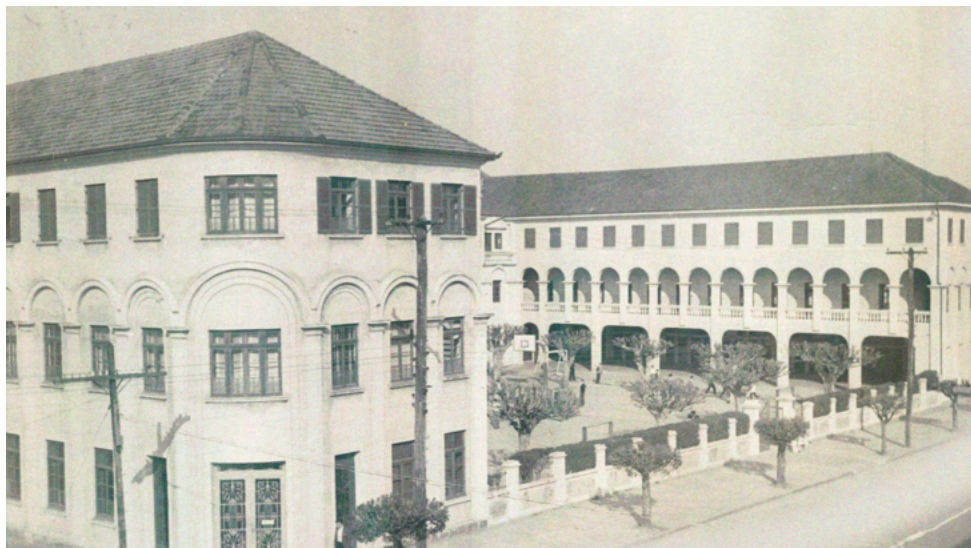
Figura 4 – Prédio na década de 70, com a ala leste finalizada.
