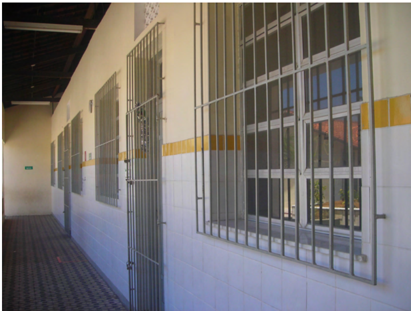
Figura 2 – Janelas e portas gradeadas e trancadas com cadeados nas salas de aula da EMEF Presidente Vargas
