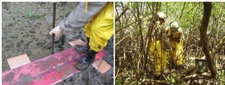
Figuras 2 e 3. Trabalhos geotécnicos para caracterização do subsolo.
