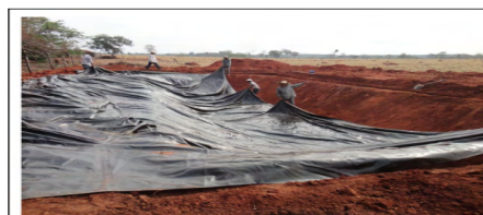
Figura 13. Detalhe da colocação da geomembrana de PVC PEAD de 0,8 mm.
