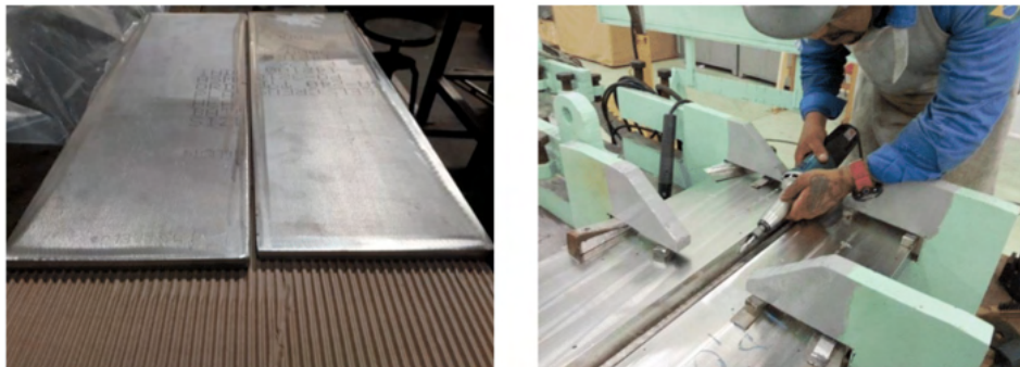
Figura 6. Corte das Chapas das amostras e preparação para a soldagem dos QPS's
