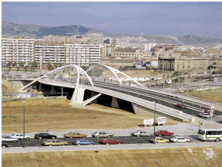
Figura 1- Ponte Bach de Roda, Barcelona, 1987
