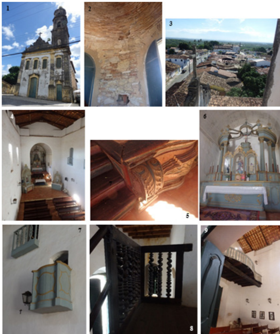
Figura 1: (1)- Fachada principal da Igreja de N. Sa do Amparo dos Homens Pardos; (2)- Alvenaria mista – Tijolos (cúpula) e pedras calcárias nas paredes com emboçamento a base de cal e argila vermelha; (3)- Cruz latina encimando o frontão, vista da janela da torre sineira; (4)- Capela-mor da Igreja vista do Coro; (5)- Ornatos do madeiramento de entrada do Altar-mor; (6)- Detalhe do Altar-mor; (7)- Vista externa do púlpito; (8)- Detalhe do gradil trabalhado em retorcimentos espiralados da parte interna do púlpito; (9)- Vista do coro (estrutura de madeira e balcão) da entrada do corredor lateral da nave principal. Fonte: SILVA, EDER D., mar. 2018.
