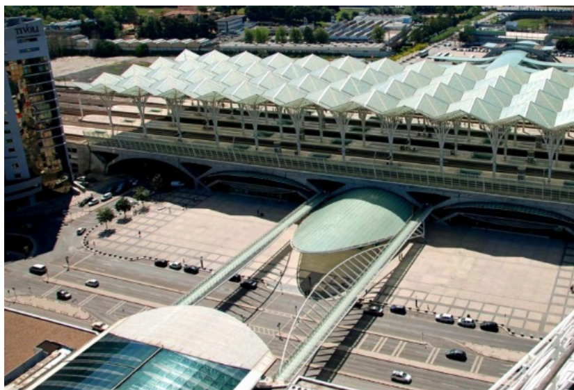
Figura 2 Estação Oriente, Lisboa, 1998. http://papodearquitectas.blogspot.com.br/2013/05/estacao-do-oriente-calatrava.html .
