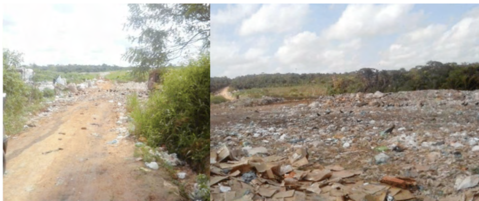
Figura 4: Lixão à céu aberto do município de Capanema.
