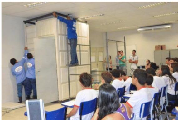
Figura 3 – Colocação da viga metálica superior – andaimes sem tábuas.
