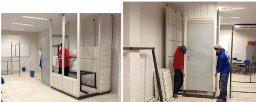
Figura 2 – Montagem do módulo do banheiro de plástico reciclado.
