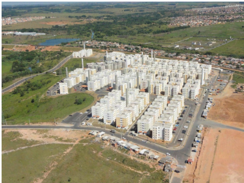
Figura 3: Foto do Residencial Sirius. Aparecimento de comércio informal em forma de barracos.
