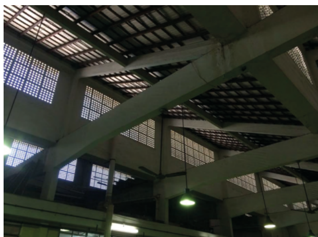
Figura 3.3 – Fotografia do interior do pavilhão de Construção Civil, onde podemos observar nitidamente o detalhamento do telhado tipo shed .
