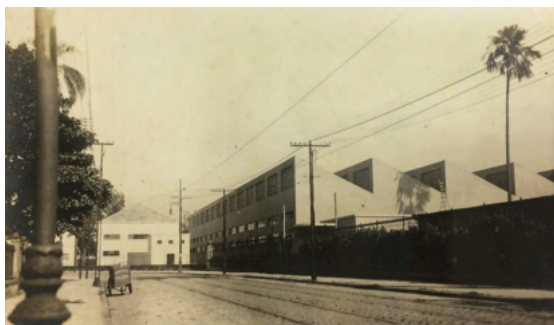
Figura 1.3 – Escola Técnica Nacional (ETN) concluída (vista da rua General Canabarro)
