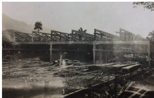
Figura 1.2 – Etapa da construção da então Escola Técnica Nacional (ETN).
