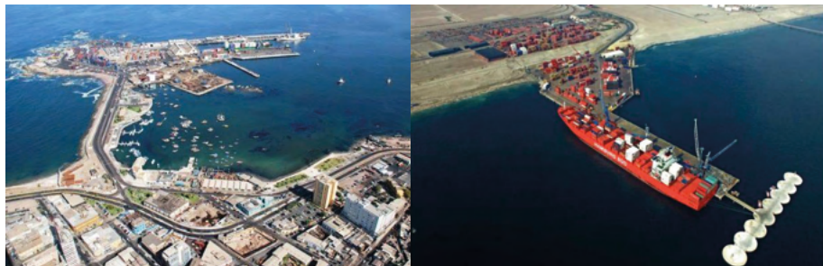
Figura 2 e Figura 3: Porto de Iquique (Chile) e Porto de Mejillones (Chile)
