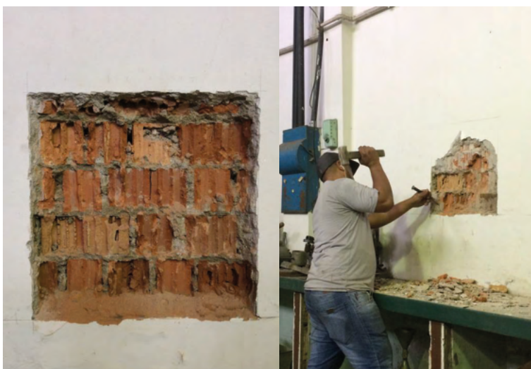
Figura 3.4 – Processo de abertura da janela de inspeção
