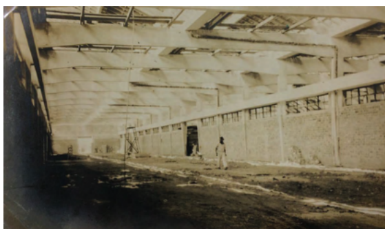
Figura 3.2 - Fotografia do interior de um dos pavilhões do CEFET/RJ – Maracanã, após a conclusão de sua construção.
