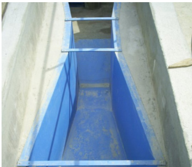
Figura 4 - Calha Parshal semelhante à utilizada na ETA São Judas.
