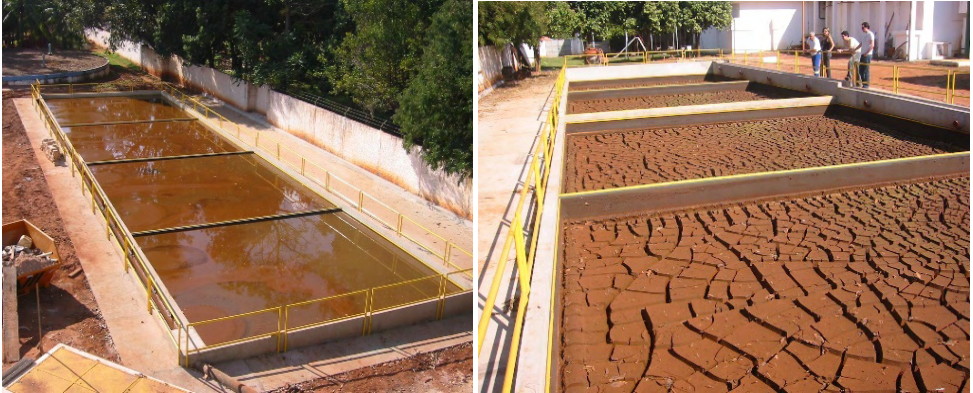
Figura 16 - Leito de Drenagem em escala real na ETA de Monte Aprazível – SP.
