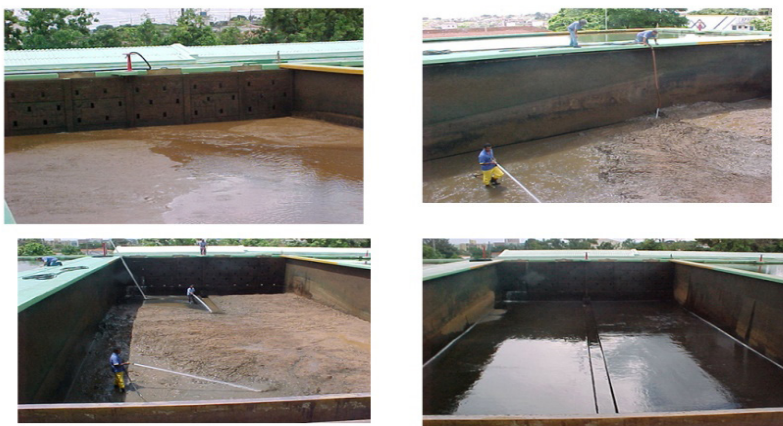
Figura 2 – Resíduos gerados em decantadores de ETAs.
