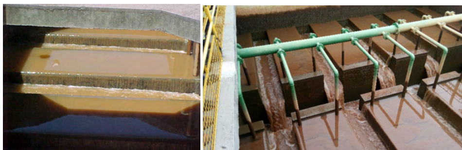
Figura 3 – Resíduos gerados nos filtros de ETAs.
