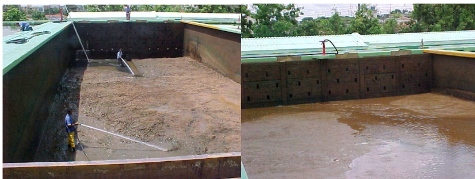
Figura 2 - Partículas retidas em tanques de decantação e limpeza dos tanques.
