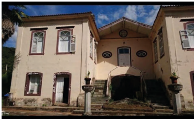
Figura 11 - Casarão antes da reforma (fachada)
