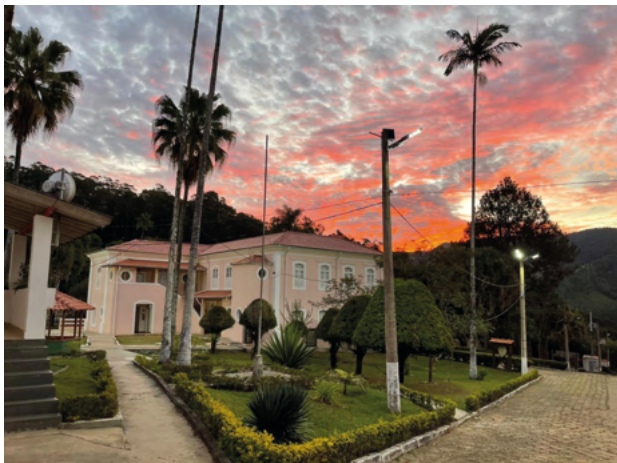
Figura 12 - Casarão depois da reforma (lateral)
