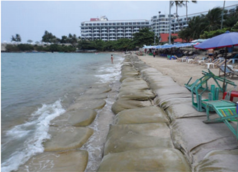
Figura 6 - Sandbags para contenção do avanço do mar
