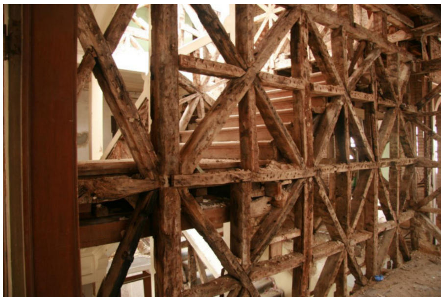
Figura 4. Técnica construtiva gaiola de pombalina.
