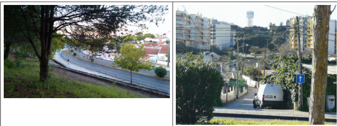
Figura 9: Na imagem à direita, variante N10 e a Quinta do Chegadinho. Na imagem à esquerda, a Quinta do Chegadinho no primeiro plano e edifícios da década de 1970 ao fundo.
