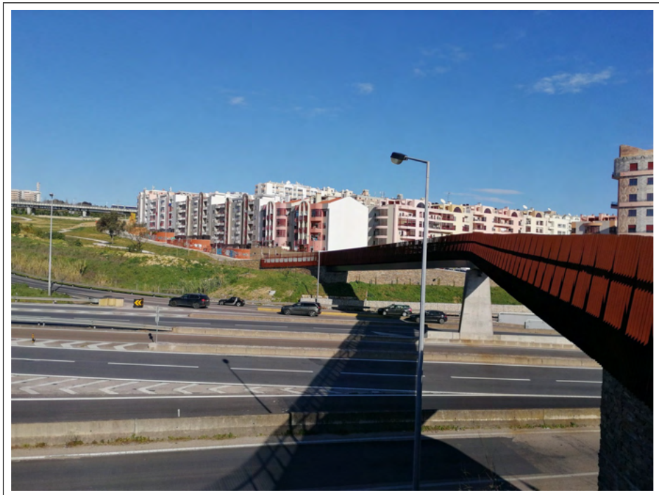
Figura 15: Vista da passarela que atravessa a via expressa A2 e conecta o Parque da Paz com a freguesia do Pragal.
