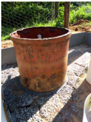
Figura 3 – Vedação entre anel e pavimento com massa de calafetar.
