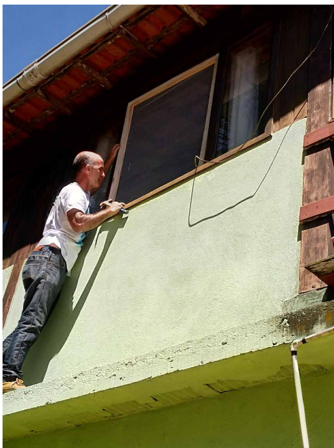
Figuras 2 e 3 – Instalação das Telas Impregnadas.
