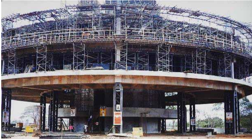
Figura 5. Pilares provisórios no canteiro de obra, bloco A.
