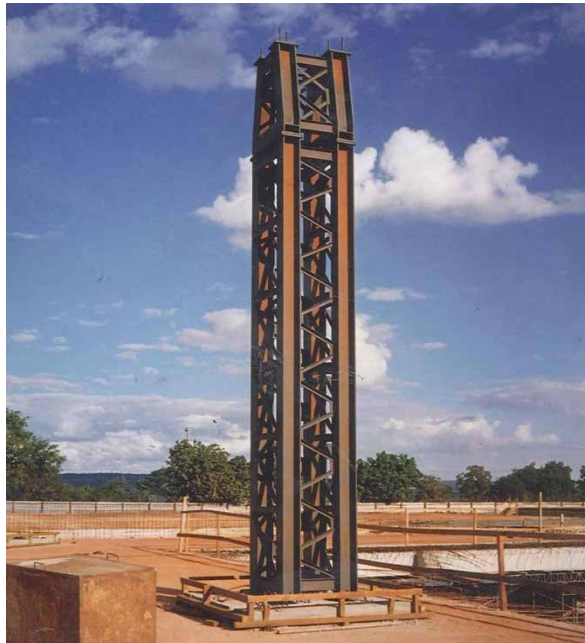
Figura 6. Pilar metálico de escoramento provisório, bloco A.
