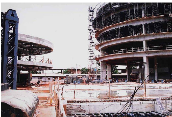
Figura 5. Edificação em fase de construção, bloco B
